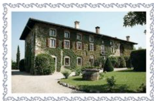
Casaforte "La Brunelde" Fagagna – UD
